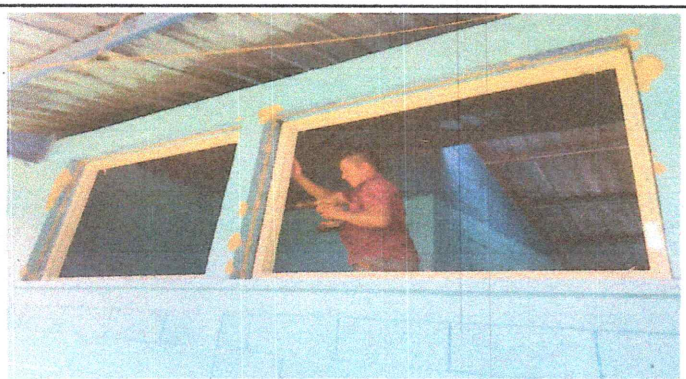
Foto 3: Se observa en la fotografía el avance de la colocación e instalación de las ventanas de la escuela.
