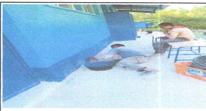
Foto 6: Se observa en la fotografía el avance de la pintura exterior de la escuela.
