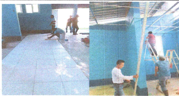
Foto1: Se observa en la fotografía el avance de la instalación del piso cerámico y la instalación de la estructura del cielo falso.
