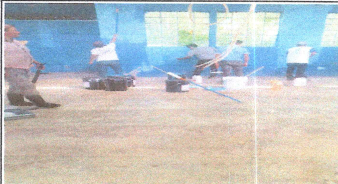
Foto 2: Se observa en la fotografía el avance de la pintura interior de la escuela.
