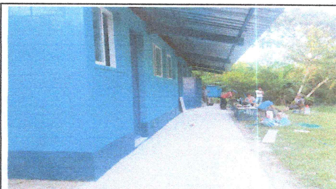
Foto 4: Se observa en la fotografía el avance del piso rustico del corredor del aula.
